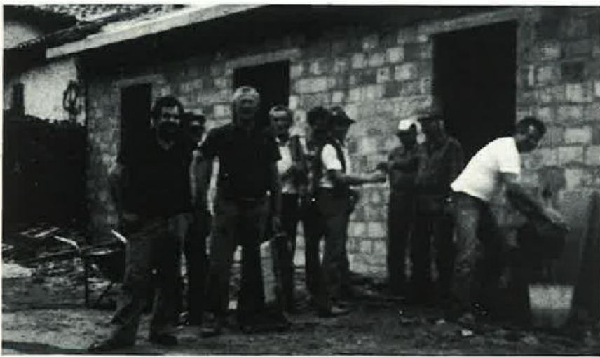
Gli Alpini del Gruppo di Paese in un attimo di sosta, davanti al fabbricato in costruzione.
